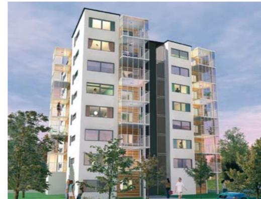
Die zwei Mehrfamilienhäuser mit 54 Wohnungen sind die ersten in Falkenberg, die entsprechend den Prinzipien des Passivhauses realisiert wurden. Angestrebt wurde ein Energieverbrauch von 45 kWh/m<sup>2</sup>a für Heizung und Warmwasser. Dies bedeutet eine Unterschreitung des derzeit geforderten Standards für neue Gebäude in Schweden um mehr als 50 Prozent.
