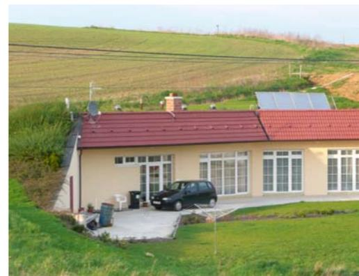
Das „Öko-Dorf“ Jizni Chlum in Zlin besteht aus „Erdhäusern“. Der Energiebedarf liegt in der Größenordnung eines Passivhauses. 60 bis 90 Prozent des Energieverbrauchs werden durch erneuerbare Energien gedeckt.
